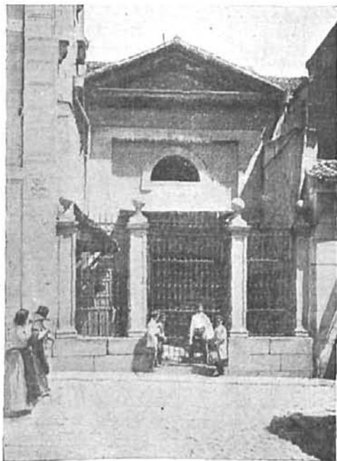
VISTA EXTERIOR DE LA CAPILLA
